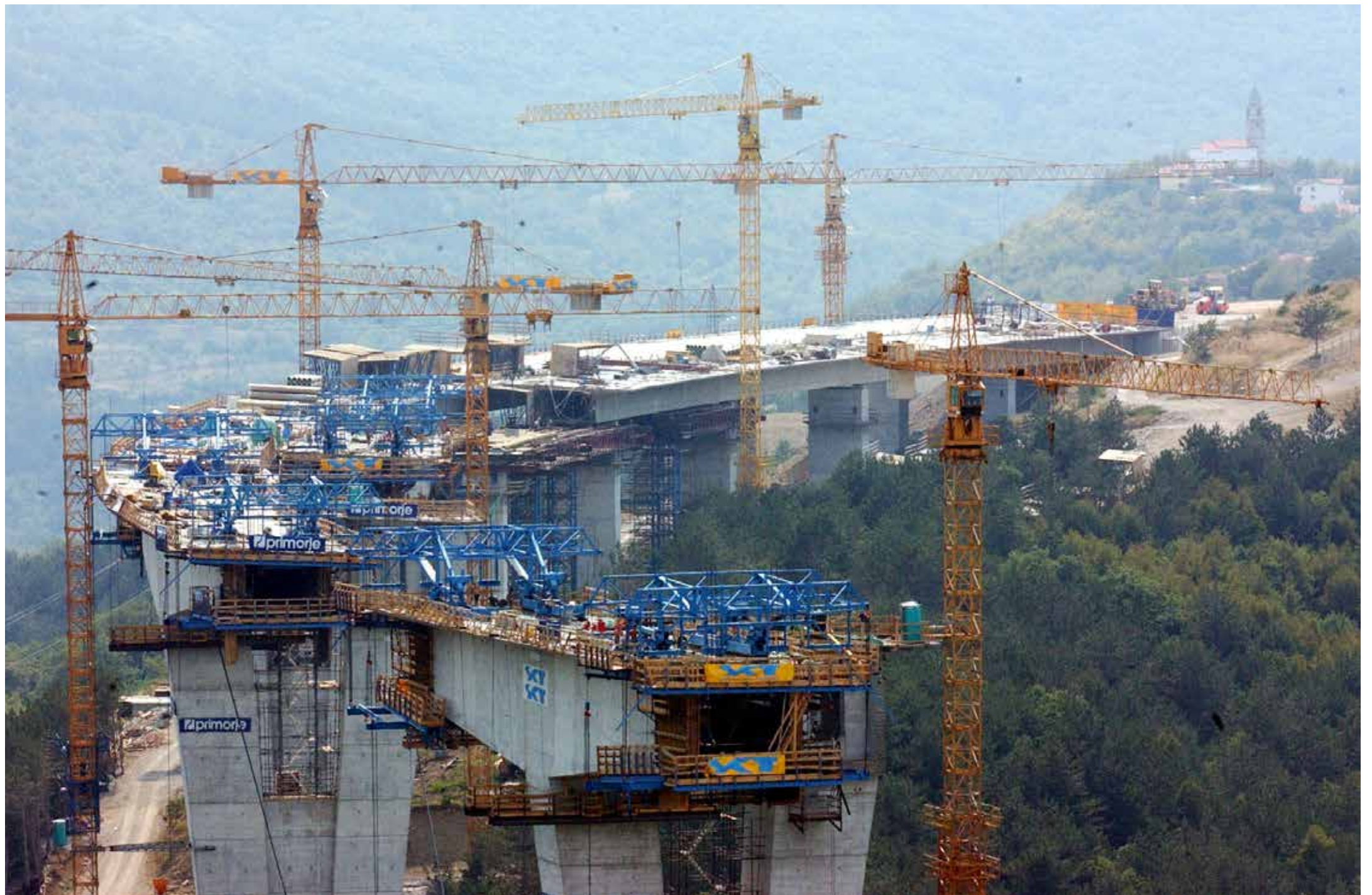
Viadukt Črni kal je bil eden večjih gradbenih projektov v zadnjih desetletjih. ▣ Jaka Adamič
